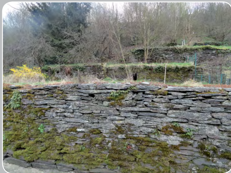
Murs en pierre sèche (rue Rompré)
