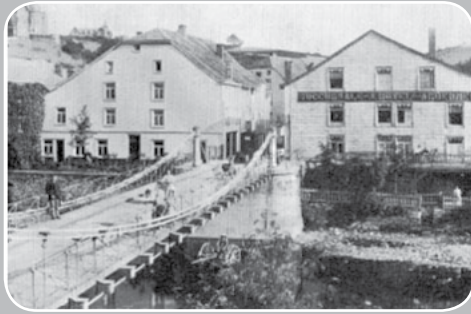
Le pont suspendu du 19 ème siècle
