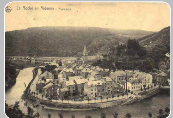
Les quais réaménagés après 1901
