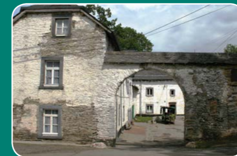
Château-ferme du Mesnil (côté rue)
