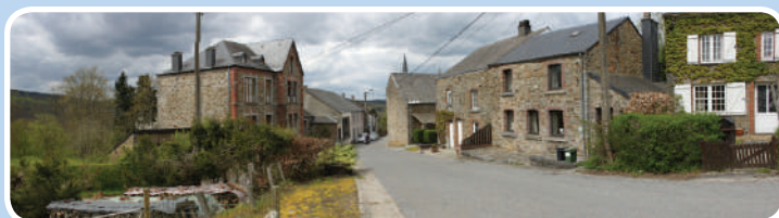
Constructions articulées de manière moins systématique, composant avec les contraintes du relief
