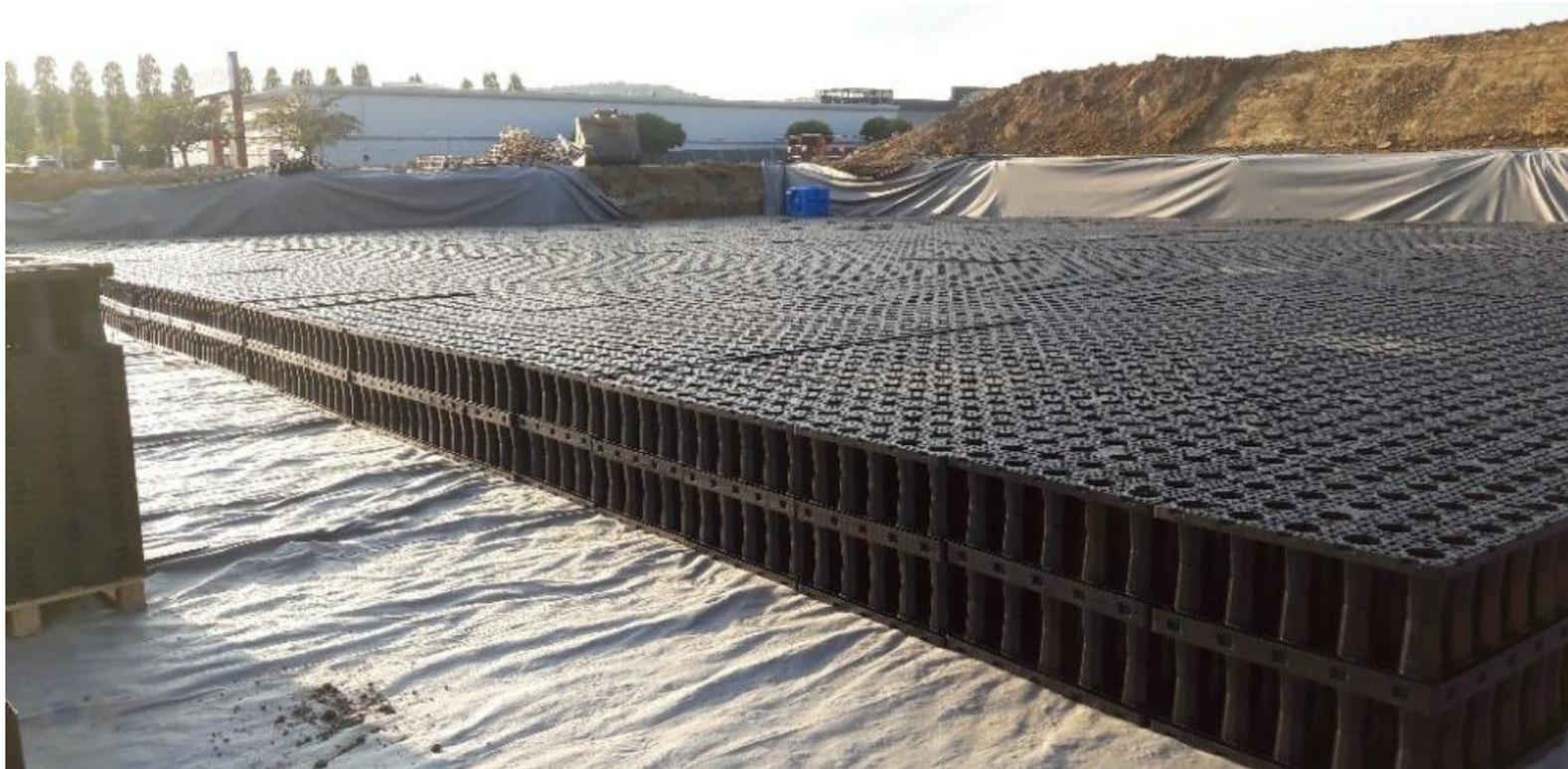
**Temporisation des eaux issues des surfaces imperméabilisées.**
