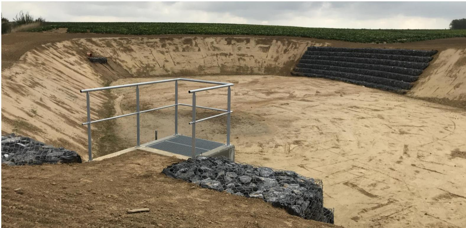
**Temporisation des eaux issues des surfaces imperméabilisées.**
