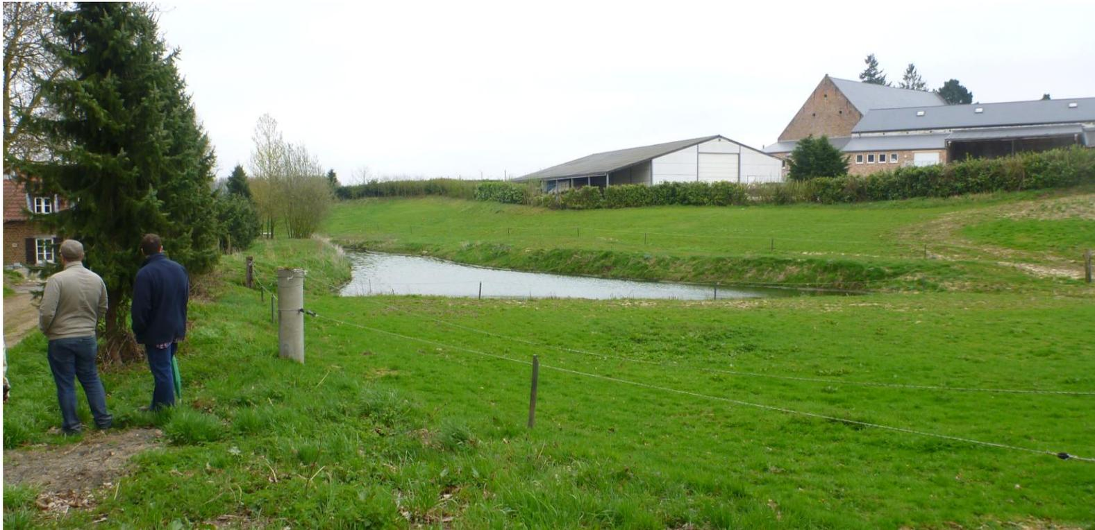
**Temporisation des eaux issues des surfaces imperméabilisées.**
