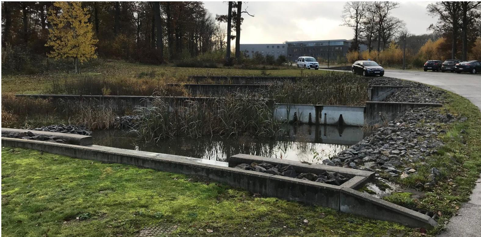
**Temporisation des eaux issues des surfaces imperméabilisées.**
