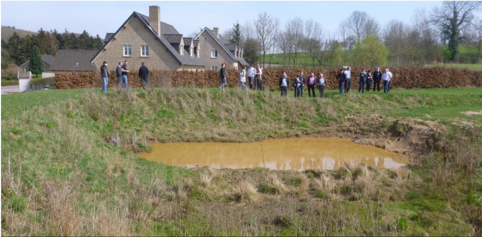
**Temporisation des eaux issues des surfaces imperméabilisées.**
